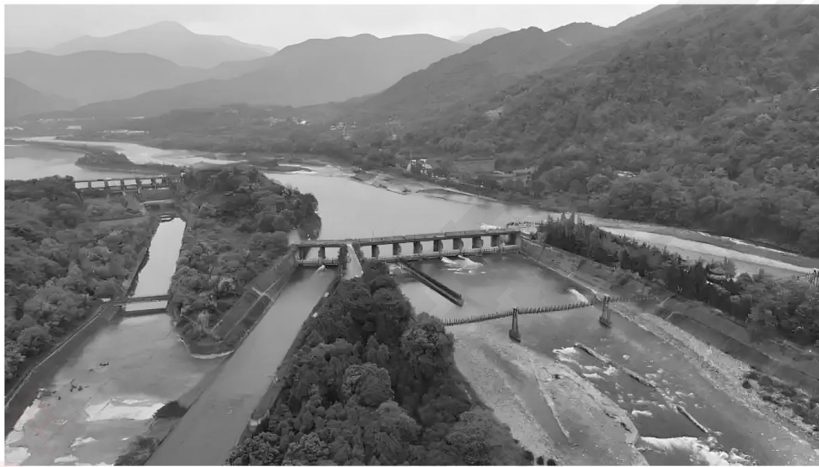
都江堰水利工程
